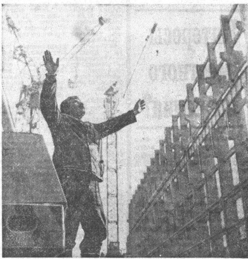
Строительство ТЭЦ «Маршала-Истор-Э». «София-пресс».
