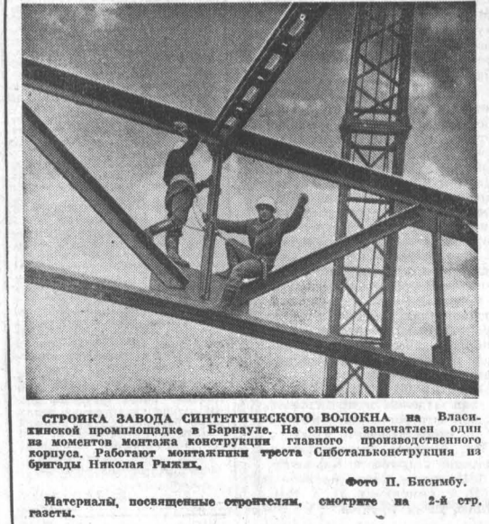
СТРОИТКА ЗАВОДА СИНТЕТИЧЕСКОГО ВОЛОКНА на Власихинской промлощадке в Барнауле. На снимке запечатлен один из моментов монтажа конструкции главного производственного корпуса. Работают монтажники треста Сибталстройиндустрия из бригады Николая Рыжых. Фото П. Бисимбу.
