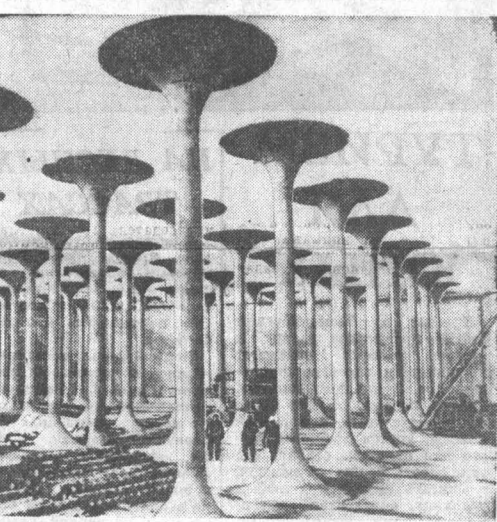
БУДАПЕШТ. Водохранилище емкостью 80 тысяч кубометров сооружается на горе Геллерт, возвышающейся над венгерской столицей. Огромный, состоящий из двух бассейнов резервуар, строительство которого должно завершиться в будущем году, будет обеспечивать бесперебойное снабжение города водой в течение всего года. НА СНИМКЕ: железобетонные опоры для поддержания перекрытия бассейна. Фото МТИ—ТАСС.
