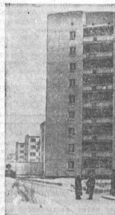
Растет и хорошеет второй по величине город Алтай — Ясно. НА СНИМКЕ: новые жилые дома по улице имени Мухоморова. Фото И. Князева.
