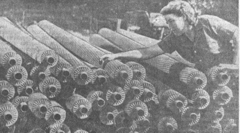
На Барнаульском заводе монтажных заготовок треста «Алтайцинмонтаж» осматривается производство холодильного, сантехнического и отопительного оборудования. Еще в прошлом году здесь «Чарышский» и в Павловской средней школе. В июле сделана первая тысяча погонных метров оребренных труб для крупных холодильных помещений. ИА СНИИМ: мастер-комплектовщик А. П. Неладово проверяет качество оребренных труб. Фото Н. Кришнина.
