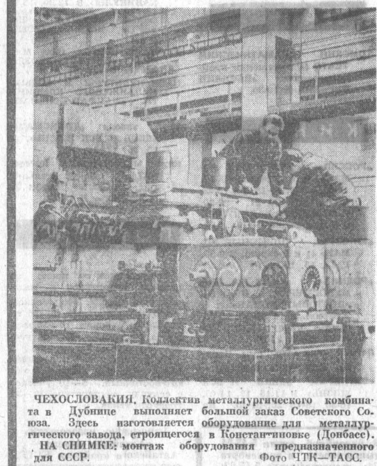
ЧЕХОСЛОВАКИИ. Коллектив металлургического комбината в Дубнице выполняет большой заказ Советского Союза. Здесь изготовляется оборудование для металлургического завода, строящегося в Констанц-Ново (Донабсе). НА СНИМКЕ: монтаж оборудования предназначенного для СССР.
