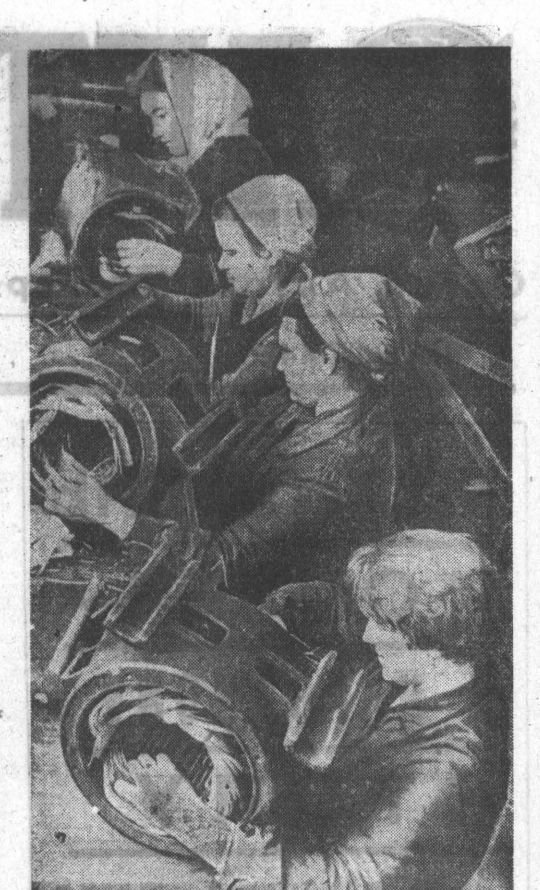
М. КРЫС, политинформатор Алтайского тракторного завода. Г. Рубцовск.
