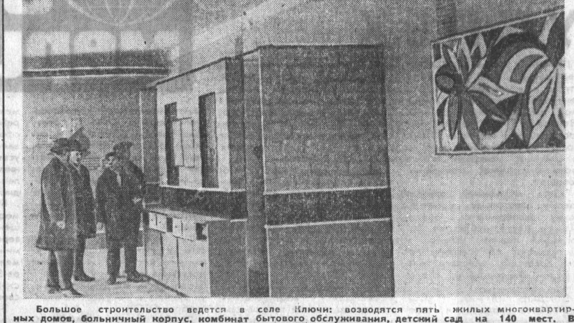
Большое строительство ведется в селе Илючи: возводятся пять жилых многоквартирных домов, большой корпус, комбинат, детский сад на 140 мест и Дом культуры на 600 мест и Дома Советов. НА СНИМКЕ: одна из новостроек — ресторан «Илючи».
