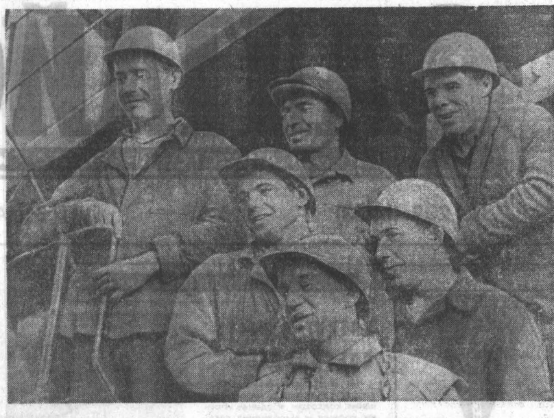
На монтаже котельной, предназначенной для снабжения горячей водой и паром двух крупнейших предприятий Барнаула — шинного комбината и завода «Сиб-Энерго». Бригада монтажников В. М. Захарова из Новокузнецкого монтажного участка треста «Сиб-Энерго». Бригада взяла обязательство закончить все монтажные работы не в ноябре, как это предусмотрено планом, а на месяц раньше срока.
