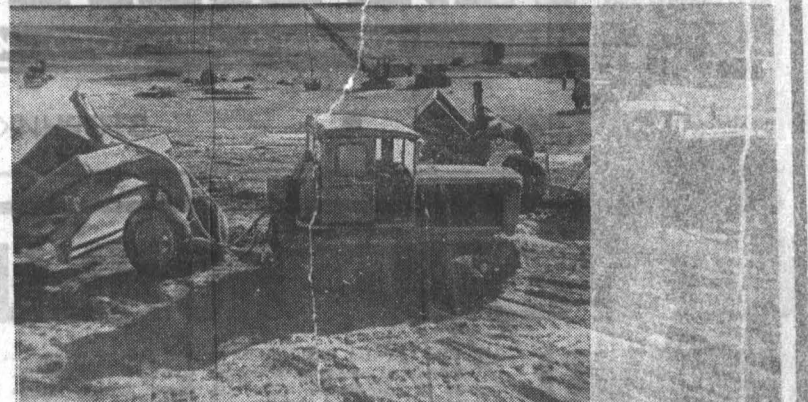
В колхозе «Завезы» Ленинского района ведется строительство пруда, площадь которого составит 75 гектаров, а емкость — 2.350.000 кубических метров воды. Ведет строительство участок Славгородского строительного треста «Алтайстрой». Строители решили закончить работу к 7 ноября нынешнего года. На снимке: на строительной площадке. Фото Б. Шлея.
