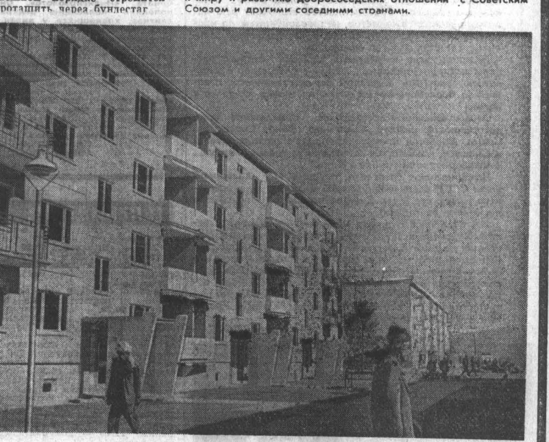
В столице Афганистана — Кабуле с помощью Советского Союза сооружаются два микрорайона. На фото: новые земельные дома.
