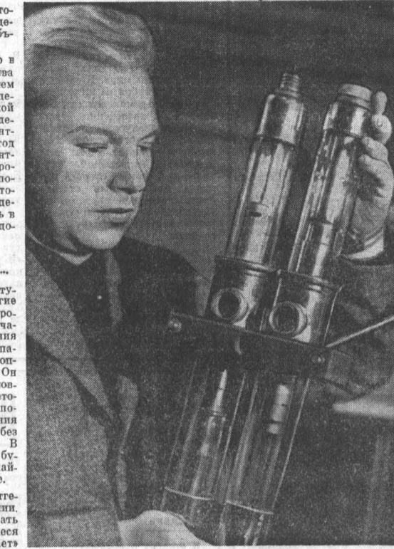
НА СНИМКЕ: молодой инженер Михаил Шурегин подготавливает рентгеновские трубки для установки в стереорентроскоп, применяемый в объемном видении. Фото О. Кузьмина. Фотохроника ТАСС.
