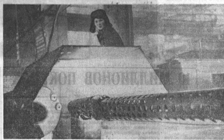
Внимание — рентгенокопия! На этом снимке вы видите рентгеновскую копию Бийского котельного завода Тамары Семенов. Еще 1—2 минуты, и сварочным швом наземного (слева) котла будет поставлен самый точный диагноз.
