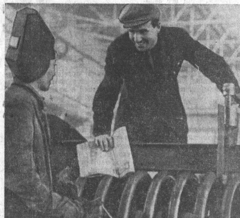
Барнаульские котельщики первыми в отечественном энергостроении осуществили идею поставки агрегатов заказчика не «россыпью», а крупными блоками. Специалисты, монтирующие котлы, дали блочной системе высокую оценку. Время монтажа сокращается вдвое, отпадает надобность в некоторых трудоемких процессах на открытой площадке.
