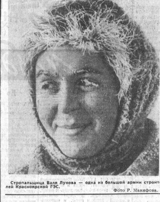
Стропальщик Валл Лунова — одна из большой армии строителей Красноярской ГЭС. Фото Р. Маянова.
