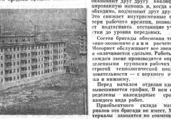
НА СНИМКЕ: крупнопанельные дома, возводимые трестом «Барнаульнистрой».
