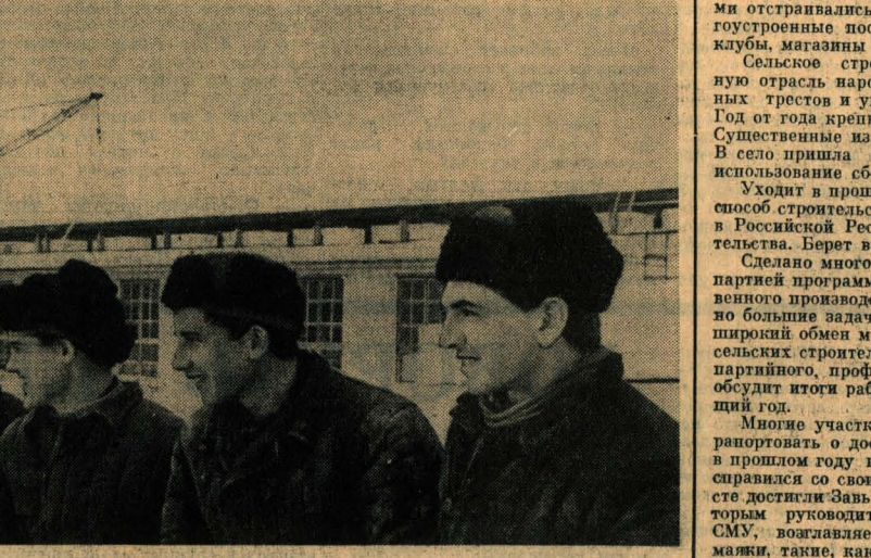
Коллектив бригады строителей большой химии. В центре — бригадир бригады Л. Мазалов.
