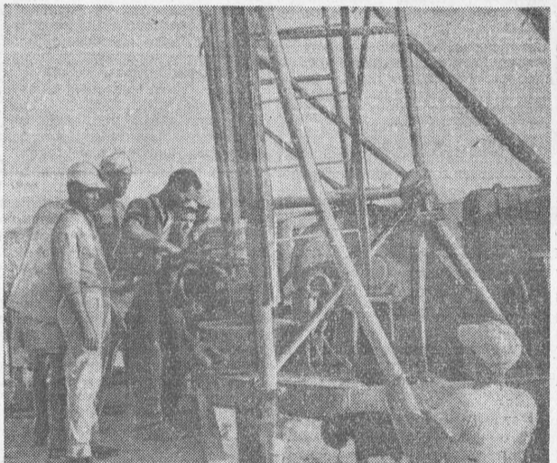
Эфиопия. В районе порта Асаб на Красном море ведутся изматывающие работы на месте строительства одного из крупнейших предприятий страны — нефтеперерабатывающего завода. Проявительством миллион тонн сырой нефти в год. Предприятие будет сооружено при содействии Советского Союза. Две группы советских специалистов уже ведут исследование грунтов и поиски воды в районе предстоящей стройки.
