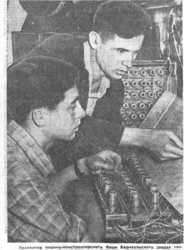
Коллектив опытно-конструкторского бюро Барнаульского завода геофизического института совместно с инженерами Ленинградского электро-технического института разработал конструкцию и изготавливает изготовленную опытного макета радиосейсмической станции. Новая станция способна производить разведку недр в радиусе двадцати километров. На снимке: радиотехник Э. Г. Туев (слева) и руководитель группы инженер-конструктор Г. Г. Круглов, принимающие активное участие в создании станции. Фото А. Калабухова.
