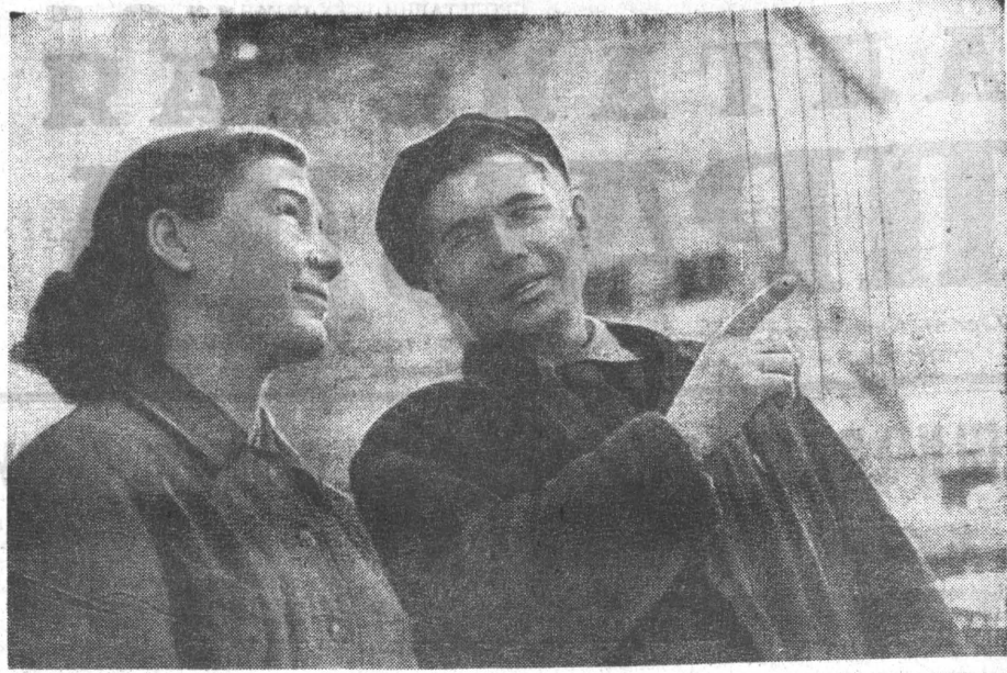
Строить! Это значит обновлять родную землю, делать ее краше. Раньше был пустырь, необжитое место, но вот пришли строители, и все изменилось — выросли жалые квартиры, задымилась заводские трубы. Хорошо строить! Это чувство понято и штукатуры Дусе Пожар. Совсем недавно она пришла на стройку. Теперь Дуся — одна из лучших работниц в Бийском СМУ треста «Алтайгазстрой». Обучил ее штукатуру делу Христофор Стенович Ухин. Он сейчас внимательно следит за ее работой, помогает сложной и делом. А учеников у Христофора Стеновича было много, и все они стали теперь отличными штукатурами. На снимке: X. Ухин и Д. Пожар на строительстве Бийского комбинированного завода. Фото и текст Я. ГАРЬКОВА.
