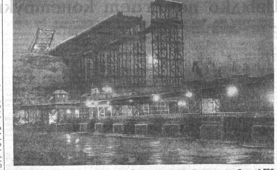
На снимке: вид на водосливную плотину и бетоновозную эстакаду на строительстве Братской ГЭС. Фото М. Минеева, Фотохроника ТАСС.
