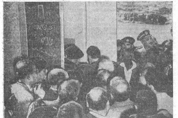
Обединенная Арабская Республика (Египетский район). 9 января в Асуане в торжественной обстановке состоялось официальное открытие работ на строительстве высотной Асуанской плотины. На снимке: во время закладки первого камня на строительстве второго канала. (Снимок принят по фототелеграфу).
