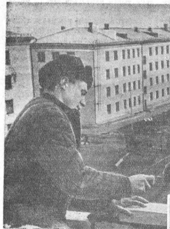
г. Барнаул. Повсюду — стройка.
