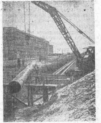
Красноярск строится. Незунаваемо изменился правый берег Енисея, где расположены десятки крупных промышленных предприятий. Здесь появились новые кварталы жилых домов, созданы новые улицы и проспекты. Сейчас идет прокладка теплофикационной магистрали в сторону строящихся кварталов правобережья. На снимке: прокладка теплофикационной магистрали. Фото Ю. Бармина. Фотохроника ТАСС.
