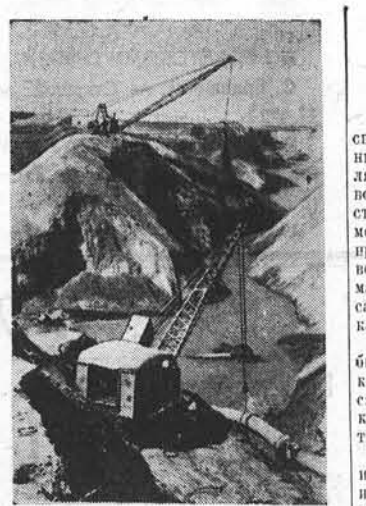
Тадрикская ССР. Директивными XX съезда КПСС по шестому пятилетнему плану предусмотрено завершение строительства Перепальной гидроэлектростанции на Вахском канале. Сейчас основные работы развернулись на сооружении напорно-стационарного узла и водосборного канала. На рывке котлована применяются мощные механизмы. Кроме этого, посредством гидросыла будет вымучено из котлована и сброшено канала около четырех миллионов кубометров грунта. Огромные массы земли перемещаются в бой на расстоянии 30 километров и сбрасываются в реку Вахш. Сейчас гидросылы подводят и концы. В работу вступают экскаваторы, сиреперы, бульдозеры, которые расширяют и отделяют откосы котлована и канала.
