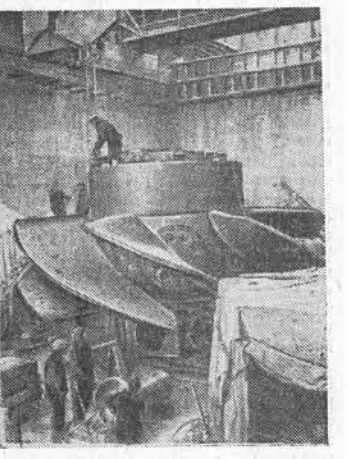
На строительстве Иркутской ГЭС. На снимке: бригада тов. Шайкина за монтажом рабочего колеса турбины. Фото М. Ишнеева. Фотохроника ТАСС.
