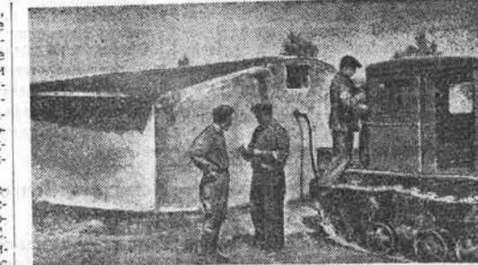
На этом снимке вы видите склад горючего, построенный в тракторной бригаде В. И. Польских из Ворошиловской МТС.
