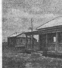
Новый полевой стан первой механизированной бригады колхоза имени Сталина. Здесь будут жить механизаторы тракторной бригады П. С. Литвинова из Ново-Егорьевской МТС, которые обслуживают эту артель.
