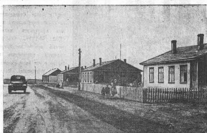
За последние два года в Табунской МТС для новоселов построено одиннадцать многоэтажных жилых домов. 29 механизаторов поставили собственные дома. Сооружены также магазины, столовая и баня. На снимке: новые четырехквартирные дома в Табунской МТС. Фото В. Николаева.
