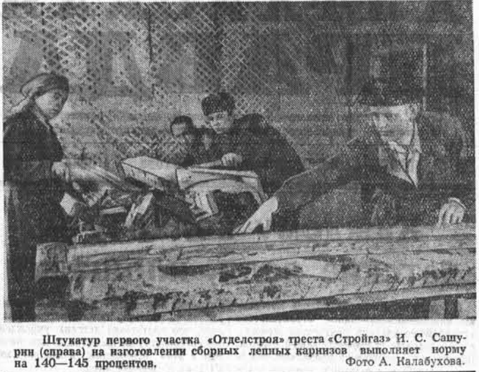
Штукатур первого участка «Отделстрой» треста «Стройгаз» И. С. Сашурин (справа) на изготовлении сборных ленточных карнизов...
