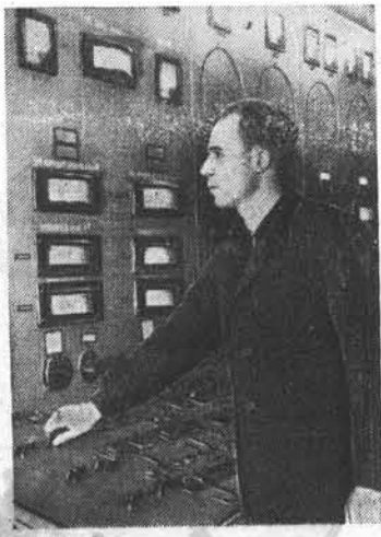
Активно участвует в предсезонном соревновании старший машинист Барнаульской ТЭЦ Н. Г. Аксенов. Он обеспечивает бесперебойную и четкую работу котельного агрегата. На снимке: Н. Г. Аксенов за работой. Фото П. Ховрина.
