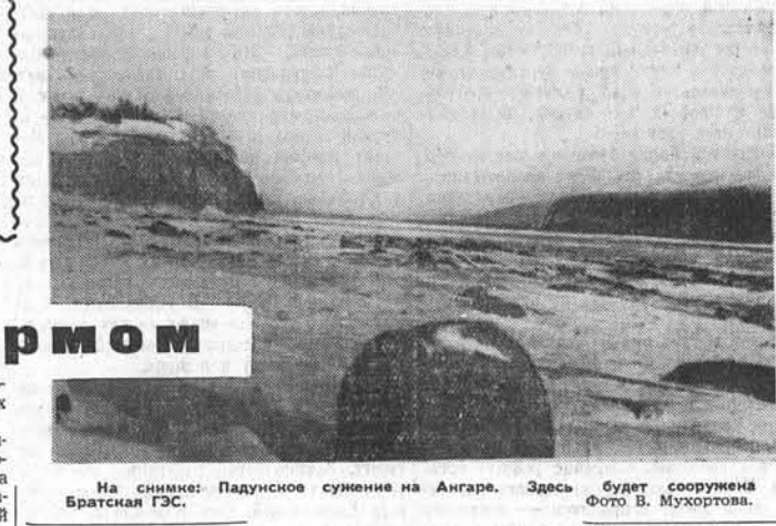
На снимке: Падунское сужение на Ангаре. Здесь будет сооружена Братская ГЭС.
