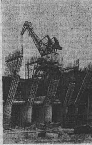
В настоящее время здесь идет монтаж четырех турбин. Передовая бригада монтажников тов. Корнунова закончила установку камеры рабочего колеса первой турбины, монтаж опорных колонн турбины второй, третьей и четвертой турбины. Сейчас бригада ведет сборку рабочего колеса второго турбоагрегата. Монтажные систематически выполняют свои задания на 200—250 процентов. Успешными темпами идет сооружение водосливной плотины. Велутся работы по изготовлению крупных железобетонных блоков для автомобильного моста, который будет проложен по плотине. На стройке действуют мощные автоматизированные бетонные заводы, бетоновозная эстакада, порталные краны, виброоборудование, бетононасосы и другое оборудование. У нас
