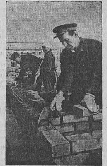
В дни предоктябрьского соревнования хорошо трудится бригада камеников Барнаульского треста «Стройгаз», возглавляемая Николаем Юрениным. Она выполняет задание на 120—140 процентов. На снимке: бригада за работой. На переднем плане — Н. Н. Юренин. Фото А. Калабухова.
