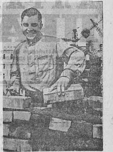
В тресте «Стройгаз» первенство в социальном соревновании занимает каменщик Владимир Москвитин. На строительстве жилого дома для рабочих и служащих хлопчатобумажного комбината он вырабатывает до двух норм в смену. На снимке: В. Москвитин за работой. Фото П. Хворина.
