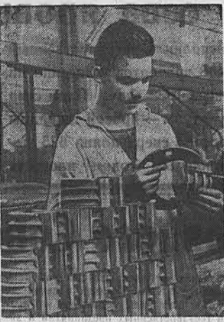
В цехе № 110 Барнаульского завода транспортного машиностроения шлифовка некоторых деталей заменяется точной обработкой. Это позволило внедрить скоростные методы резания, увеличить производительность труда на 30 процентов, улучшить качество деталей. На снимке: токарь Геннадий Морозков, повысивший сменную выработку до 130 процентов, проверяет качество деталей. Фото П. Ховрина.
