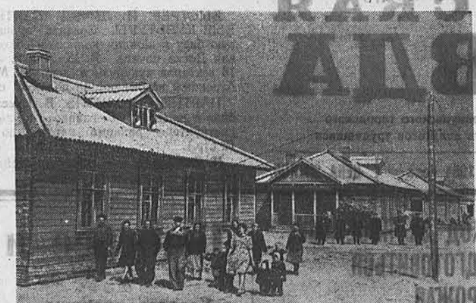
Большое строительство развернулось в Златопольской МТС. Кулундинского района. Здесь сооружаются типовые мастерские, четыре гаража для тракторов, мотобайков и автомашин, сарай для сельхозмашин, склад для запчастей, электростанция, а также жилые дома и бани. Работы ведет мостовая колонна строительства № 12, коллектив которой обязался завершить все строительные работы в июле этого года. На снимке: новые двухквартирные дома для механизаторов Златопольской МТС. Фото В. Николаева.
