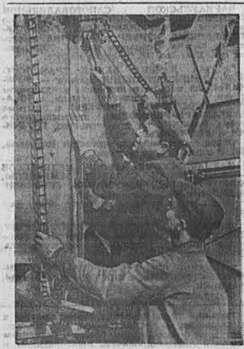
Коллектив Благовещенской МТС готовится к уборке урожая. Механизаторы ремонтируют комбайны. На снимке: комбайнеры М. И. Слюсарев и А. Ф. Третьяков регулируют цепь транспортера. Фото А. Калабузова.
