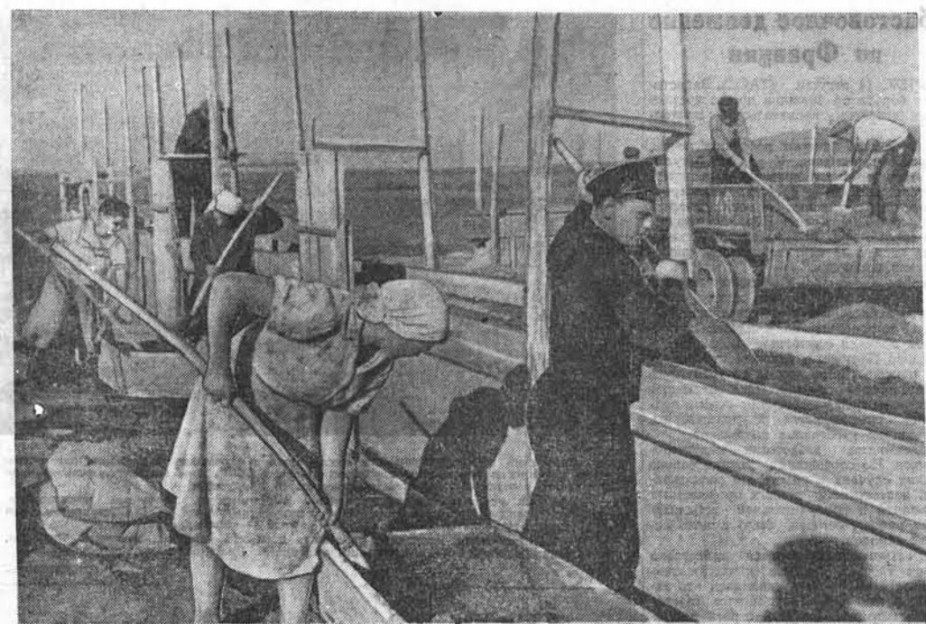
Колхозники сельхозартеля «Прогресс», Петропавловского района, усиленными темпами ведут заготовку кормов и строительство помещений для общественного скота. На снимке: колхозница Р. И. Бугакова и бригадир строительной бригады В. Ф. Замтин на строительстве свинарника. Фото А. Калабухова.
