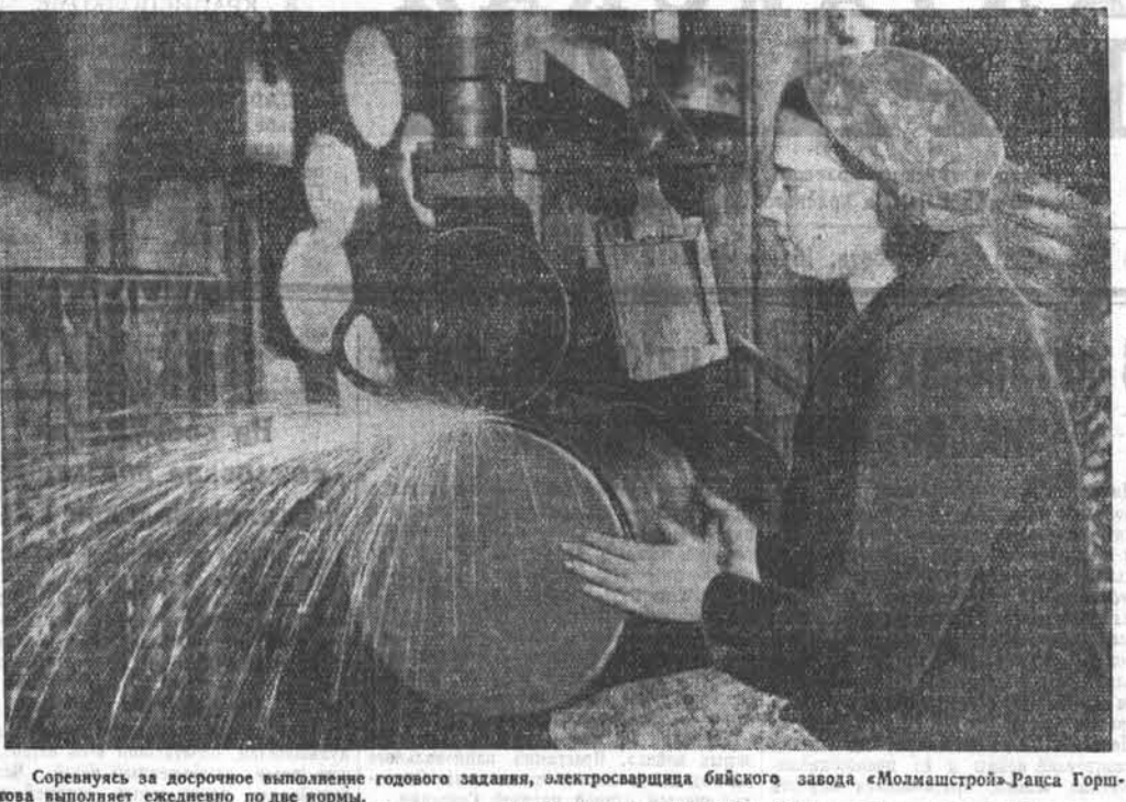
Соревнуюсь за досрочное выполнение годового задания, электросварщица бийского завода «Молжстрой» Раиса Горшкова выполняет ежедневно по две нормы. НА СНИМКЕ: стахановка Раиса Горшкова за работой. Фото А. Калбухова.
