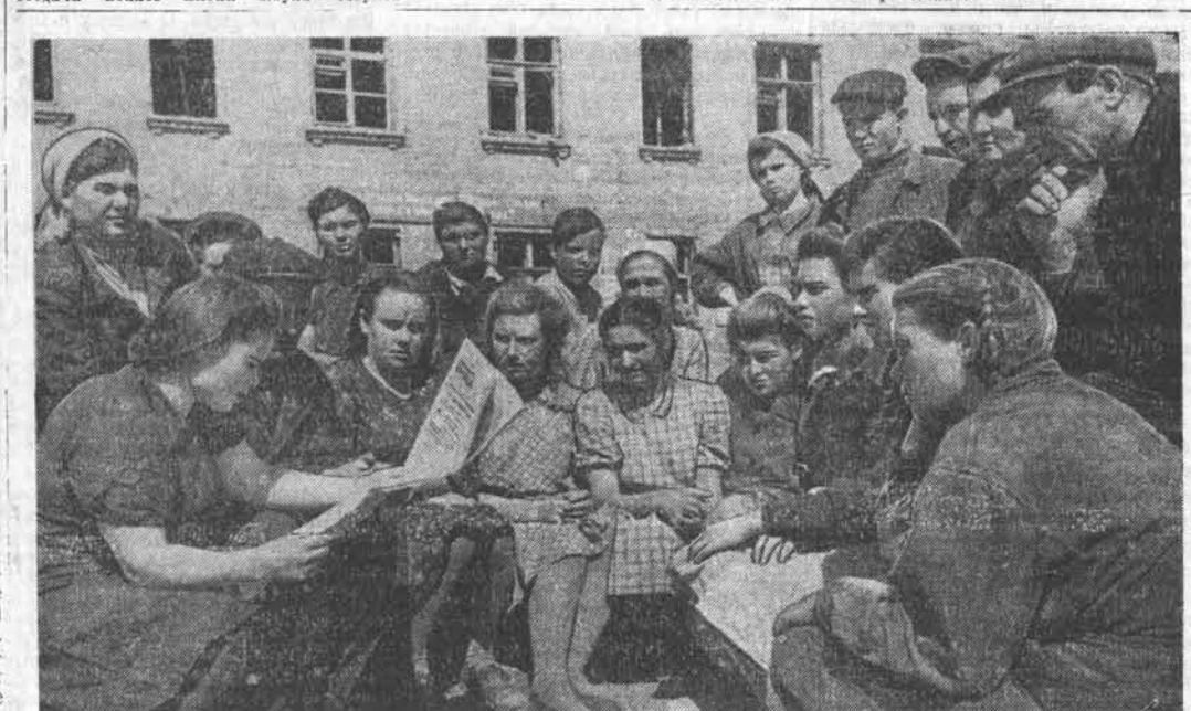
Ознакомились с проектом директив XIX съезда партии по пятому пятилетнему плану развития СССР, бригада штукаторов 2-го стройуправления треста «Стройгаз», которой руководит тов. С. В. Устинов, взяла обязательство к 1 сентября закончить штукатурку десяти квартир и фасада дома № 2, ежедневно выполнять нормы на 140 процентов. НА СНИМКЕ: агитатор Е. Ананьева знакомит строителей с историческим документом. Фото А. Калабузов.
