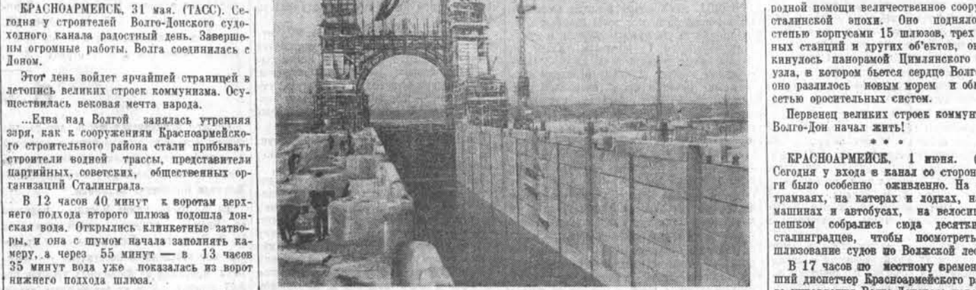
Волгодонстрой. Камера 13-го шлюза, заполненная донской водой. Фото С. Кропанинкого.
