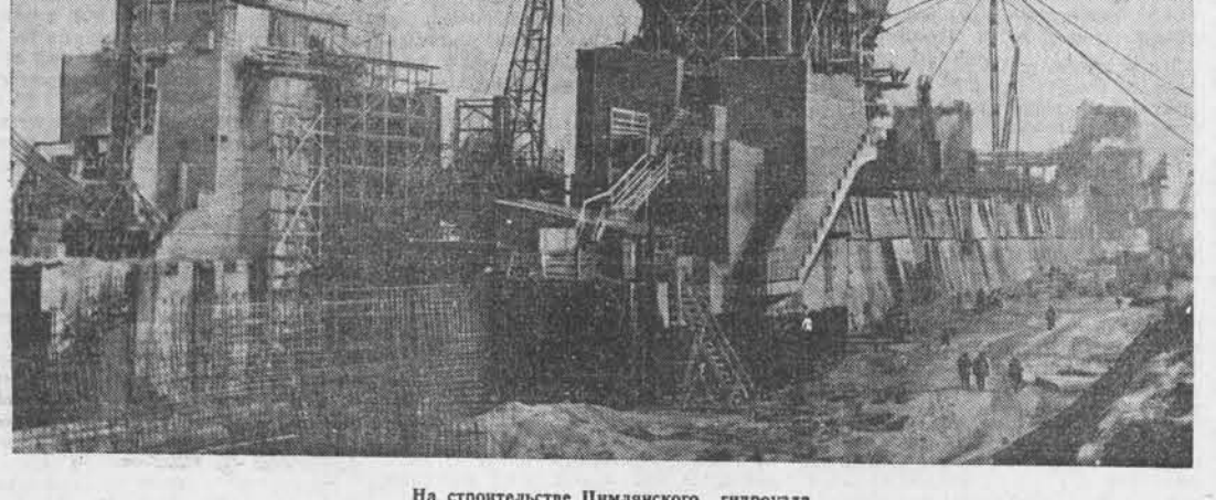
На строительстве Цимлянского гидроузла. Фото Л. Портера. (Фотохроника ТАСС).
