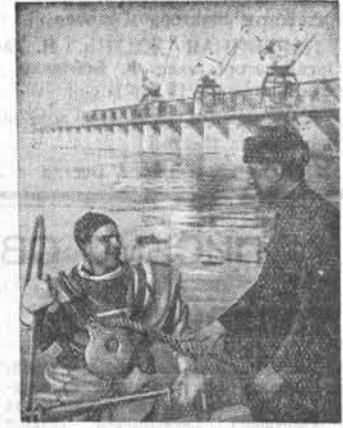
На строительстве Цимлянского гидроузла. Страница водолаза Александр Чичка (справа) подготавливает водолаза Георгия Скабуна к спуску под воду.
