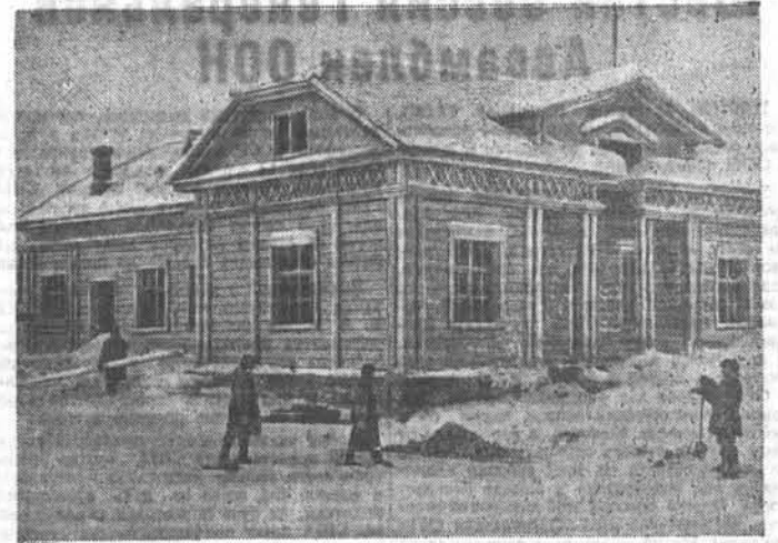
На станции Смазново на Южсибе заканчивается строительство красного уголка. В нем будет большой зал, стационарная киностанция. Работы ведет передовая строительная бригада Я. И. Ануфриева. НА СНИМКЕ: новое здание красного уголка. Фото Н. Суворовова.
