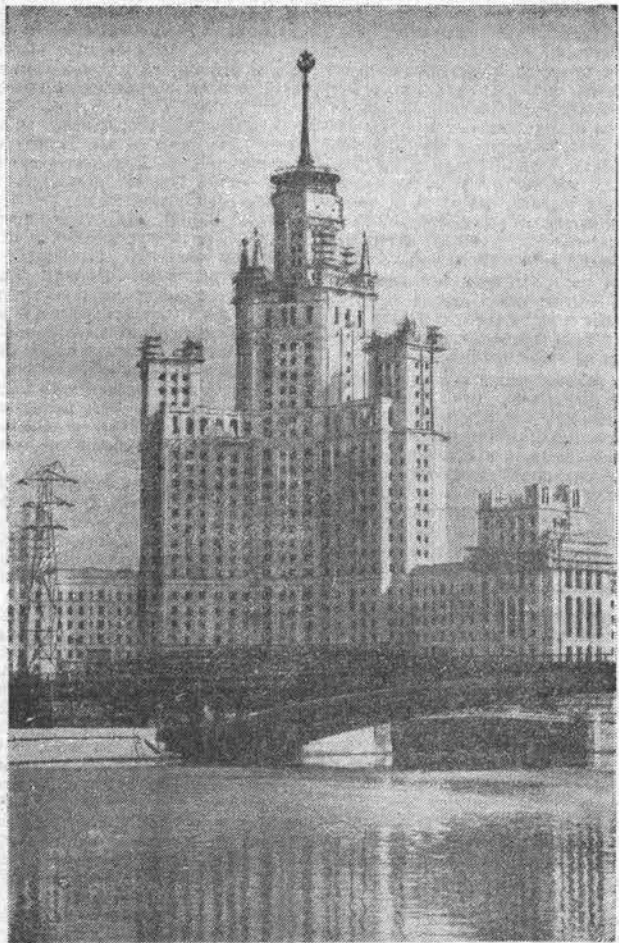
МОСКВА. Строительство высотного здания на Котельнической набережной. Фото Н. Кулешова. (Фотохроника ТАСС).
