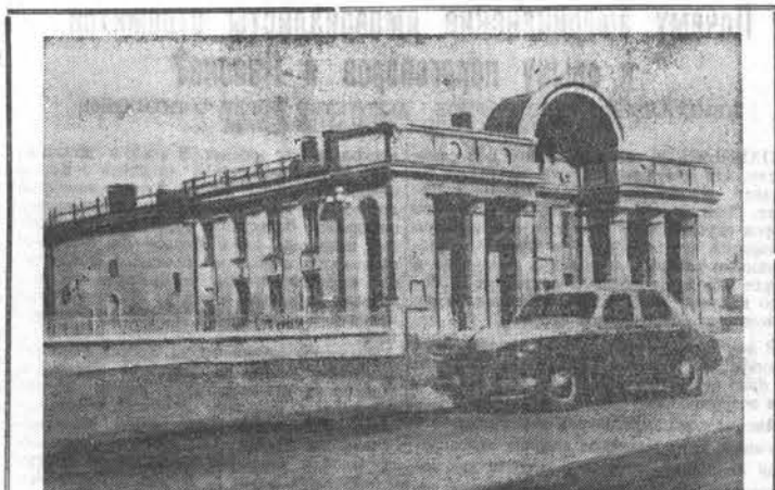
С каждым годом все больше благоустраиваются рабочие поселки Алтайского тракторного завода имени М. И. Калинина. В 1950 году тракторостроителям сдано в эксплуатацию десять хорошо благоустроенных домов с центральным отоплением. В 247 квартирах разместились более 300 семей. Все квартиры электрифицированы и радифицированы, а в 64-квартирный дом по ул. Гвардейской, № 1 поступает холодная и горячая вода. В текущем году введены в строй еще один 64-квартирный дом по ул. Гвардейской, 24-квартирный дом по ул. Сталина, частично сдана в эксплуатацию четырехэтажная гостиница площадью 2000 квадратных метров. Гордостью алтайских тракторостроителей является новый кино клуб на 550 мест. По своей архитектуре — это одно из красивейших культурно-просветительных учреждений края. НА СНИМКЕ: рабочий клуб алтайских тракторостроителей. Фото В. Манен.
