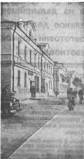
Трест «Стройгаз» для своих рабочих и служащих построил на Восточном поселке в Барнауле благоустроенные жилые дома.
