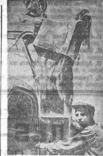
Шofer второго стройучастка Южисба Николай Дмитриевич Шейкин на подкове грунта из-под экскаватора в насыпь выполняет дневные нормы на 200—210 процентов.
