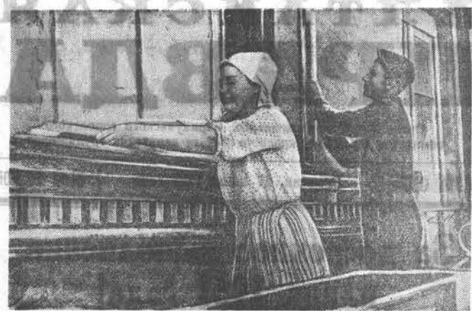
В гор. Чесноковке заканчивается отделка 24-х квартирного дома для строителей вагоностроительного завода. В соревновании, развернувшимся на стройке за быстрое окончание работ, высоких показателей добилась штукатур Анастасия Казанина. НА СНИМКЕ: А. Казанина за работой. Фото А. Калалубова.
