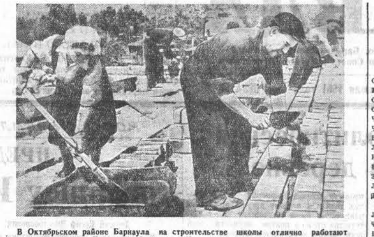
В Октябрьском районе Барнаула на строительстве школы активно работают каменщики бригады Николая Сергеева. Их ежедневная выработка составляет 180-190 процентов.
