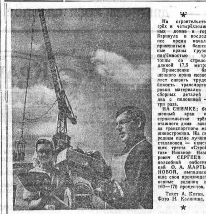
На строительстве грек и четырехэтажных домов в гор. Барнауле в последнее время начали применяться башенные краны грузоподъемностью три тонны со стрелой длиной 17,5 метра. Применение башенного крана позволяет снизить трудоемкость транспортировки материалов и сборочных деталей в два с половиной раза.
