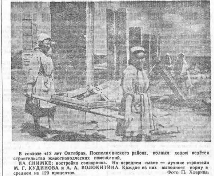
В совхозе «12 лет Октября», Поспелинского района, полным ходом ведётся строительство животноводческих помещений. На снимке: постройка свиноводки. На первом плане — лучшие строители М. Г. КУДИНОВА и А. А. ВОЛОКИТИНА. Каждая из них выполняет норму в среднем на 120 процентов. Фото П. Ховрица.
