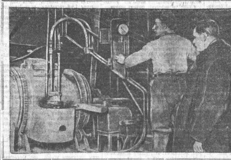
Инженеры и стахановцы Алтайского тракторного завода имени М. И. Калинина настойчиво работают над внедрением передовых методов лития. Сейчас здесь внедряется отливка деталей методом наморачивания, предложенным научным сотрудником Уральского политехнического института В. М. Ксенофонтом. Новый способ значительно повышает качество лития, обеспечивает экономию металла до 30 процентов. Подобные компактные установки способствуют сокращению литейных площадей, повышают культуру производства.
